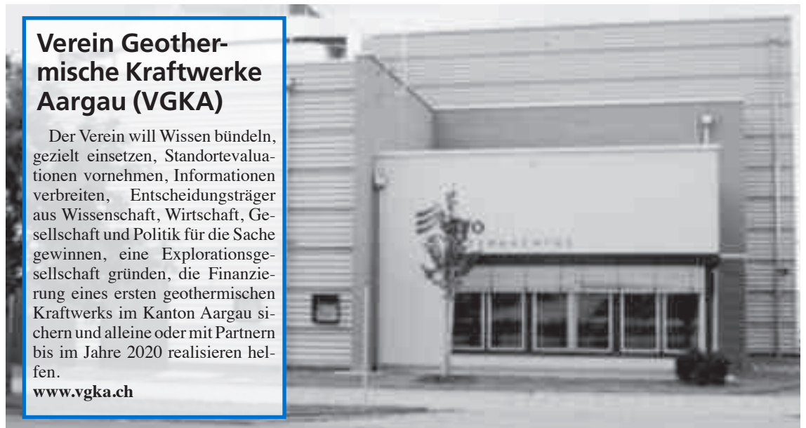
Geothermische Kraftwerke (im Bild Unterhaching, D): Liefern Bandenergie der Zukunft.
